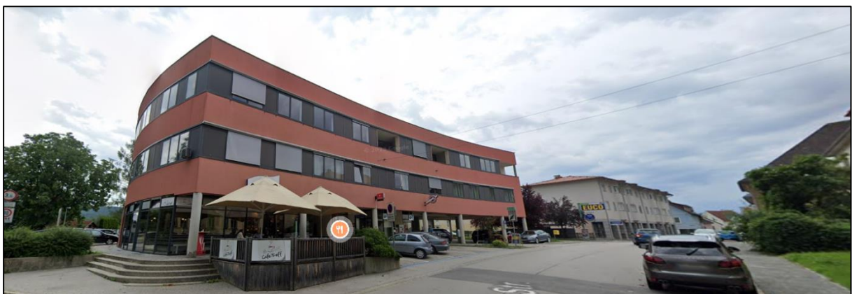
Abbildung 3: Bestandsgebäude in Griffner Str. (Quelle: Google)
